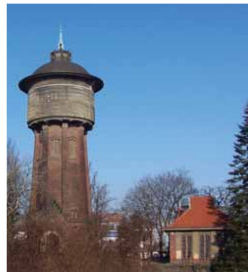
Vodojem na Zelené lišce v Michli z roku 1906
