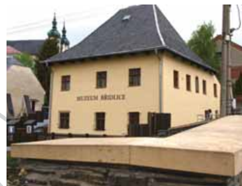
Budova Muzea břidlice v Budišově nad Budišovkou původně sloužila jako mlýn
