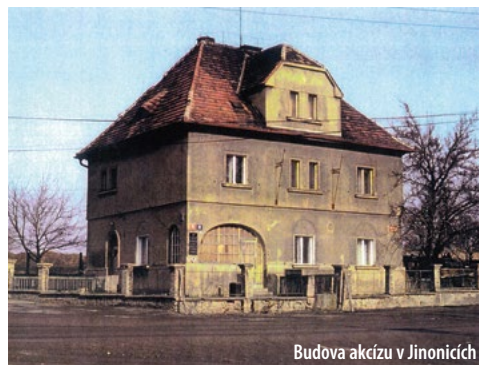
Budova akcízu v Jinonících
