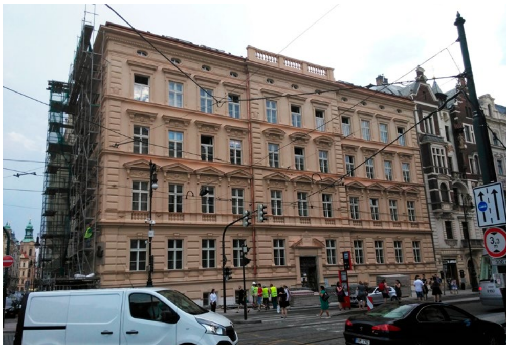
Dům č. p. 71 Na Kocandě v Křižovnické ulici v průběhu rekonstrukce. Foto Petr Starec, 2017 © Muzeum města Prahy
