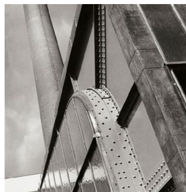
Kolín, elektrárna ESSO, detail průčelí, 1932, Malostranský archiv Jaroslava Fragnera
