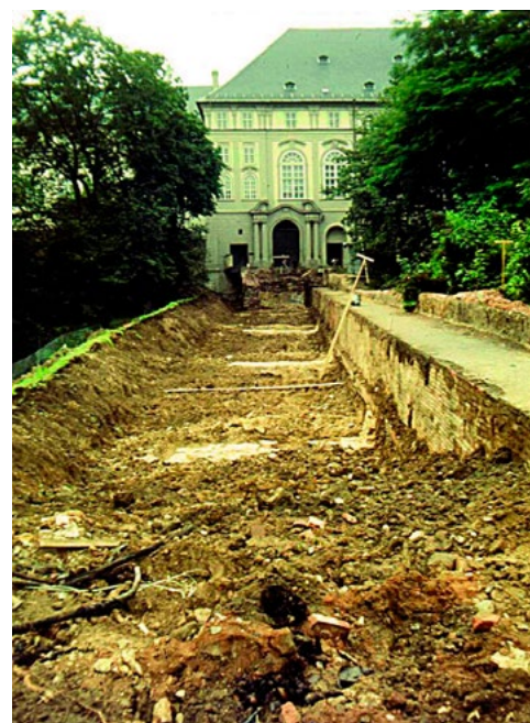
Prašný most v průběhu archeologického výzkumu v roce 1987 s patrnými pilíři mostu po odbagrování svrchní části násypu. Foto Ivana Boháčová. © Archeologický ústav AV ČR, Praha, v. v. i.
