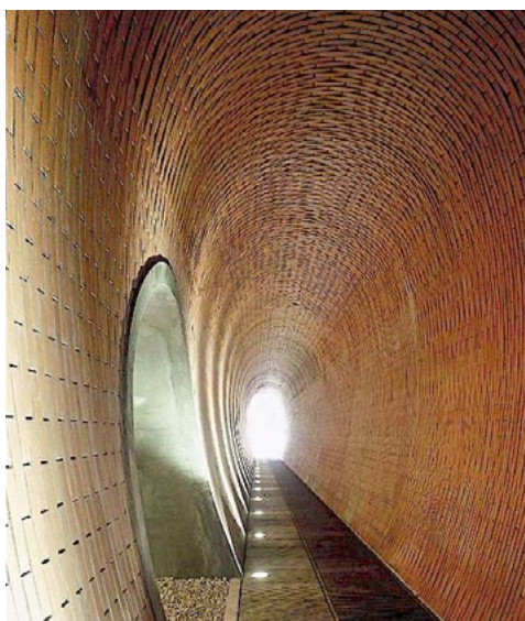
Průchod tělesem Prašného mostu s otevřeným pohledem na prezentovanou část jeho pilíře. Foto Jan Malý. © AP atelier
