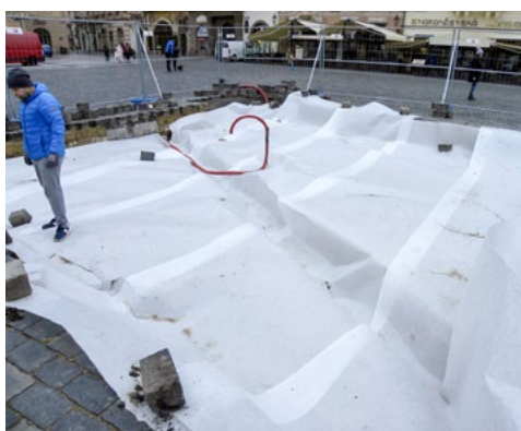
Pozůstatky historických základů byly překryty a ochráněny vrstvou geotextilie. Foto František Flek. © Národní památkový ústav, územní odborné pracoviště v Praze
