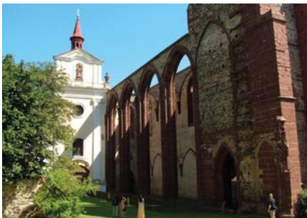
Barokní kostel na místě chóru a nedokončená gotická loď
