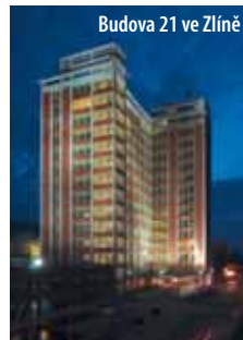
Budova 21 ve Zlíně
