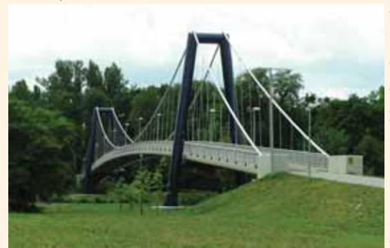
a) Lávka přes Labe u Mělníka b) Licoměřická lávka c) Lávka přes Labe v Kolíně
