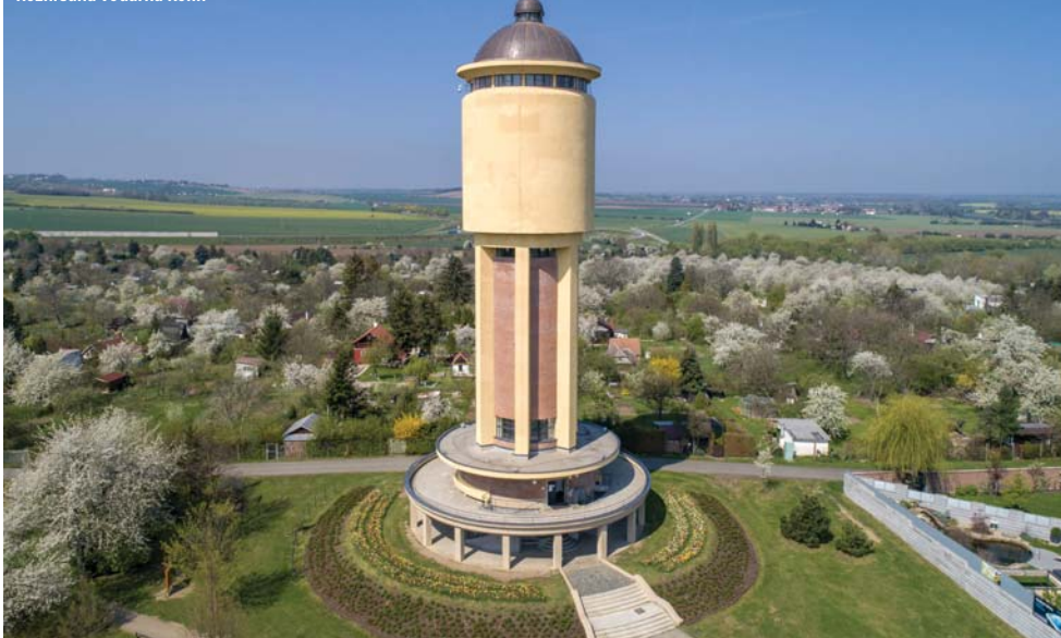
Rozhledna Vodárna Kolín
