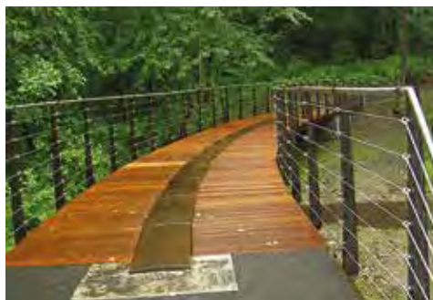
Lávka na cyklostezce v Zásadě
