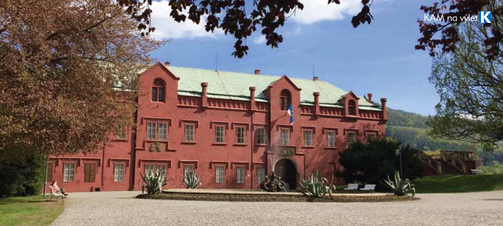
Průčelí zámku Klášterec nad Ohří
