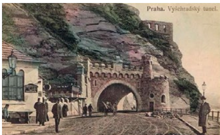
Vyšehradský tunel na dobové pohlednici, cca 1907
