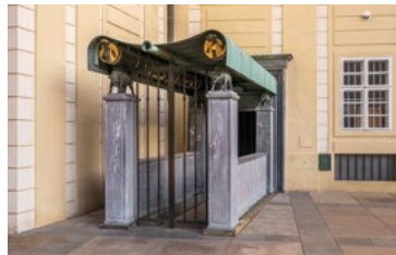
Byčí schodiště, Pražský hrad
