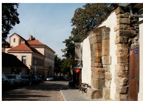
Torzo severní věže středověké brány s pískovcovými armaturami a pozůstatky portálu (foto Ivana Boháčová)
