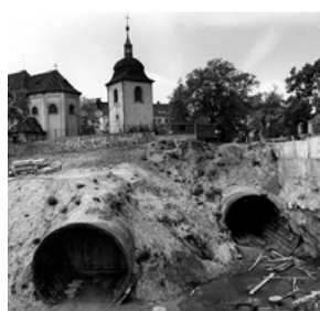
Stavba metra C
