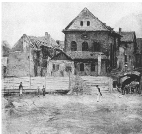
Barokní Cikánova synagoga byla jednou z nejvyšších staveb Židovského Města a její strany byly zpevněny opěrnými pilíři. Podobně jako Maiselova byla postavena uvnitř domovního bloku mezi Cikánskou a Rabínskou ulicí. Na jejím místě dnes stojí domy č. p. 131 a 132 v Bílkově ulici mezi ulicemi Pařížskou a Elišky Krásohorské. Olejomalba Jana Minaříka z doby okolo roku 1905. © Muzeum hlavního města Prahy
