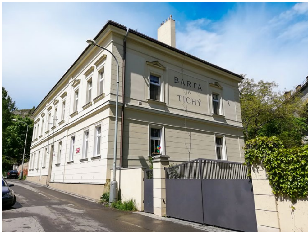
Provozní budova vápenky a cementárny Barta & Tichý na břehu Dalejského potoka v pohledu od jihu. Foto M. Churavý, 2021
