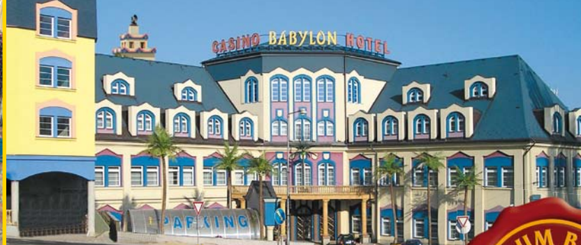
VŠE POD JEDNOU STŘECHOU
