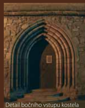
Detail bočního vstupu kostela
