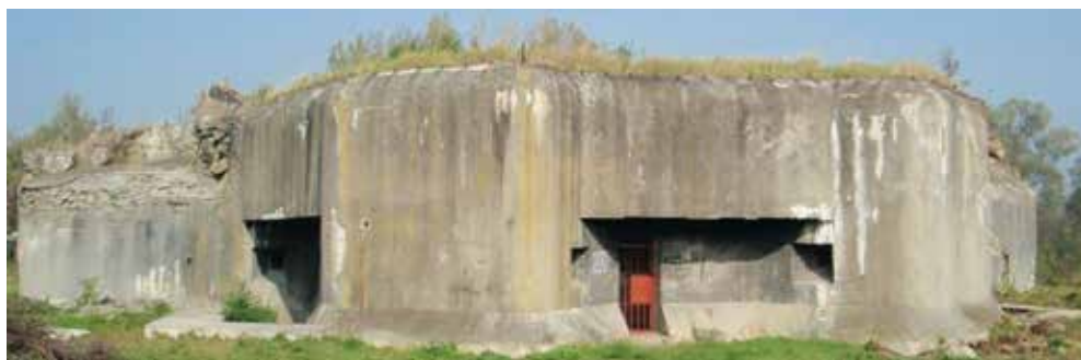
Objekt předválečného Československého opevnění MO-S37
