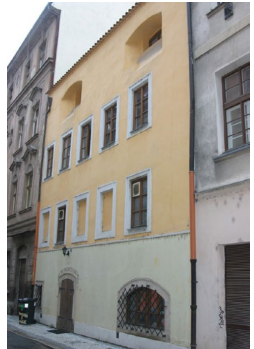
Fasáda domu U tří modrých koulí č. p. 521 v ulici V Kotcích uchovávala v nejvyšším patře dvě okna bazilikálně převýšené gotické střední lodí kotců. Foto autor, 2007
