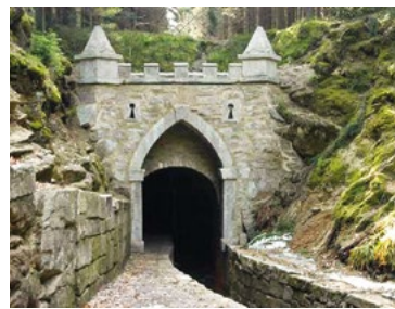
Horní portál tunelu Schwarzenberského kanálu u Jeleních Vrchů
