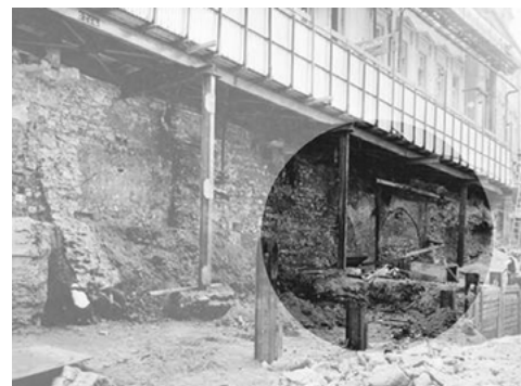
Pohled na západní frontu ulice Na Můstku, kde se v červnu roku 1976 podařilo odhalit pozůstatek opukového mostku (ve zvýrazněném kroužku) a opěrných zdí hradebního příkopu. © Archiv Dopravního podniku hl. m. Prahy, a. s.
