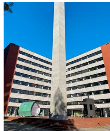
Fakulta architektury ČVUT v Praze, realizace 2009–2010
