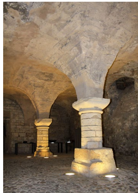
Hlavní místnost (severní část) spodního podlaží v pohledu od jihu s klenbami nesoucími stopy otisků dřevěného šalování (výdřevy). Foto archiv autora (2014)
