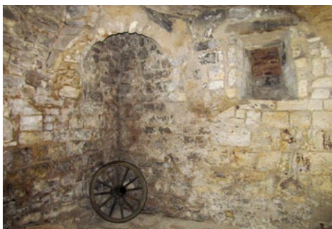
Jižní místnost suterénu s otopným zařízením v rohu místnosti v pohledu od východu. Foto archiv autora, 2012
