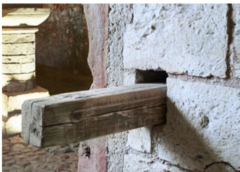
Kapsa ve zdivu se zasouvací závorou zabezpečující přístup do jižní místnosti spodního podlaží. Foto Zuzana Kačerová, 2013. © Archeologický ústav AV ČR, Praha, v. v. i.
