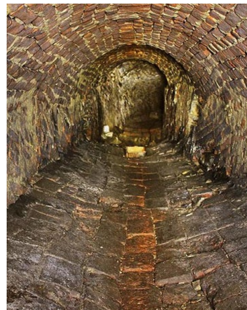
Pohled do vnitřní části revitalizované románské kanalizace pod Strahovským klášterem. Foto J. Pařez. © Národní památkový ústav, generální ředitelství
