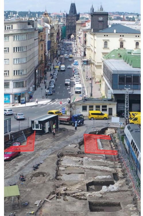
Průhled Hyberskou ulicí k Prašné bráně s vyznačením odkryvu průjezdu a části severní (vpravo) a jižní (vlevo) věže Horské brány (červeně). Foto Jan Růžička, upravil Martin Vyšohlíd. © Archaia Praha z. ú.
