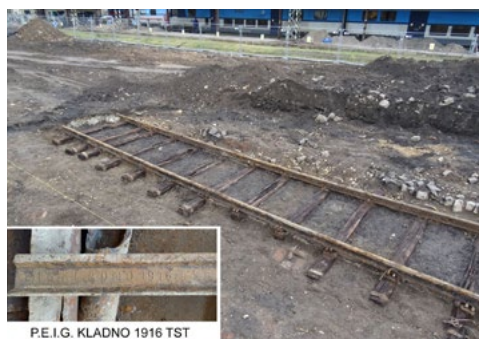
Část odkrytého historického kolejiště umožňujícího příjezd parních lokomotiv k podzemním nádržím na vodu z období druhé světové války. Vlevo dole kus kolejového pole s vyznačeným místem a rokem výroby (P.E.I.G – Prager Eisenindustrie Gesellschaft – ocelárny a válcovny v Kladně; 1916) a druhem oceli (TST – Thomasstahl). Foto Martin Vyšohlid. © Archaia Praha z. ú.
