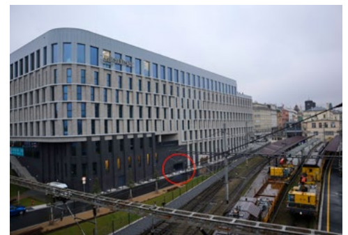
Novostavba hotelu Hyberská v pohledu od severovýchodu z magistrály. Mezi budovou a kolejářským nálezu U Horské brány. Okno s prezentací průběhu obezdění barokního bastionu se nachází v červeném kroužku. Foto Vojtěch Kašpar, 2024. © Archaia Praha z. ú.
