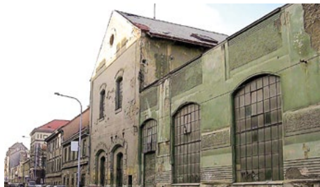
Továrna Breitfeld & Daněk v Pernerově ulici v Praze před rekonstrukcí
