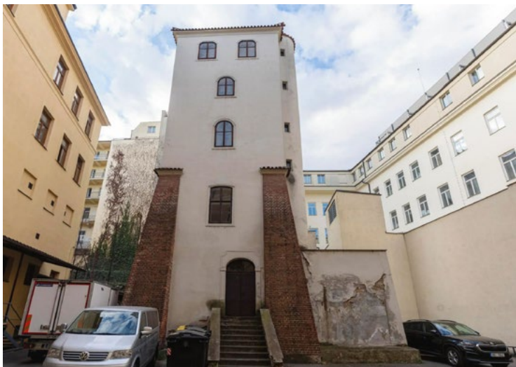
Hradební věž staroměstského opevnění na dvoře za domem č. p. 314 v pohledu od severu z průjezdu z Bartolomějské ulice. Foto M. Šula, 2026.
