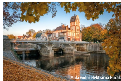
Malá vodní elektrárna Hučák
