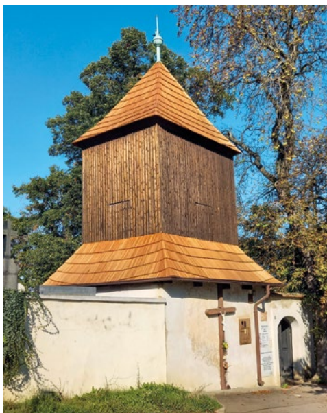
kostel sv. Vavřince Praha – Jinonice, Vavřínecká, Praha 5, k. ú. Jinonice – havarijní oprava šindelové krytiny zvonice u kostela sv. Vavřince
