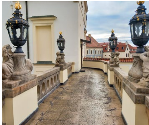
Arcibiskupský palác, Hradčanské náměstí 56/16, Praha 1, k. ú. Hradčany – restaurování kamenných prvků pozdně barokní spojovací chodby na nádvoří Arcibiskupského paláce
