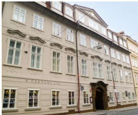
Karmelitská 379/18, Praha 1, k. ú. Malá Strana – oprava fasády
