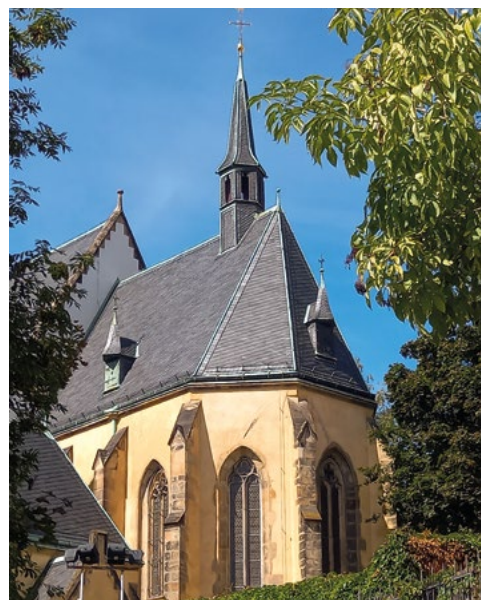
kostel sv. Apolináře, Apolinářská, Praha 2, k. ú. Nové Město – střecha presbytáře
