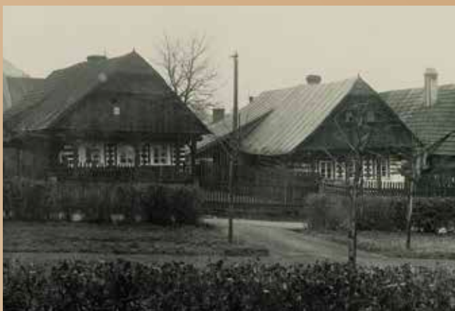
Nejdochovalejší stavbou s cennou podsíní je dnes čp. 259 (vlevo), vedlejší dům čp. 258 již dnes bohužel nestojí (vpravo).
