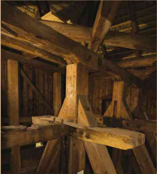
Trámoví ve zvonici se zvonovou stolicí
