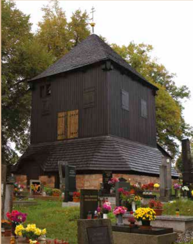
Dřevěná zvonice po rekonstrukci proběhlé v letech 2009–2010
