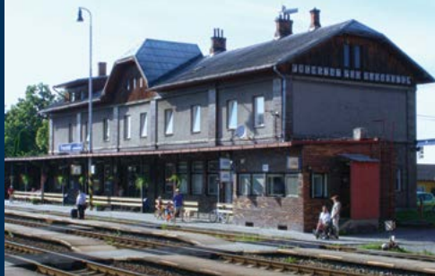
Nádražní budova před rekonstrukcí
