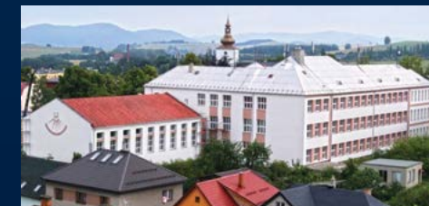
Pohled na budovu ZŠ Tyršova s tělocvičnou
