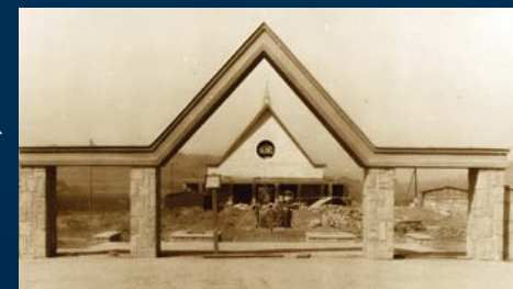
Výstavba nového hřbitova. 1965–1970
