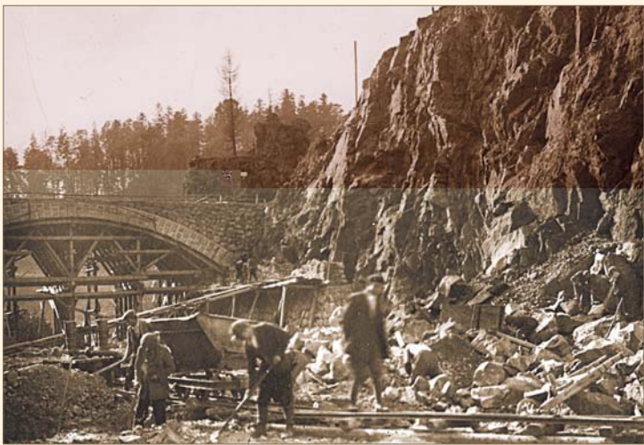
Výstavba silničního mostu přes odpad bezpečnostního přelivu (1925)
